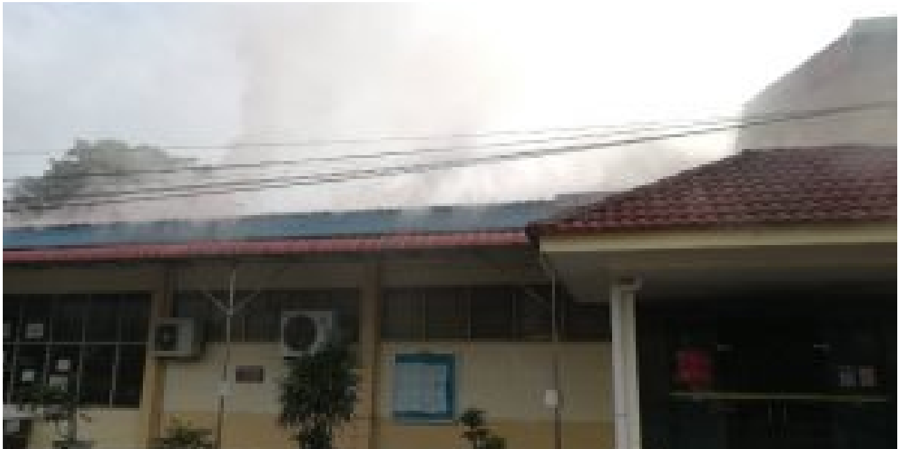
Bangunan JKR Elektrik terbakar
